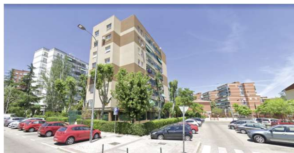
Fig. 4 Edificios residenciales en Fuenlabrada.
