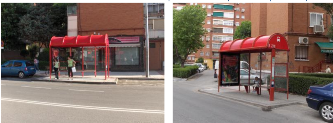
Ilustración 49.- Problemas accesibilidad por insuficiencia espacio lateral: paradas 16 y 62
