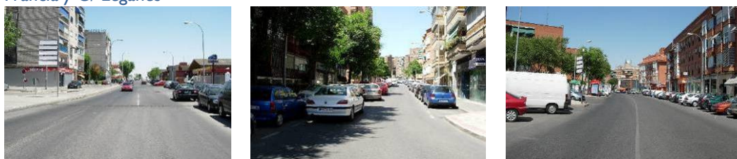
Ilustración 65 Calzadas sobredimensionadas en el centro urbano. C/ Constitución, C/ Francia y C/ Leganés
