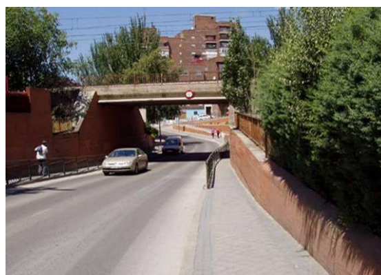
Pasos bajo la vía del ferrocarril en la calle Móstoles y Málaga.
