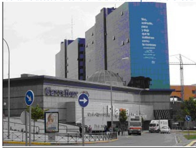
Ilustración 105 Puerta de acceso al centro Plaza Estación por calle Grecia
