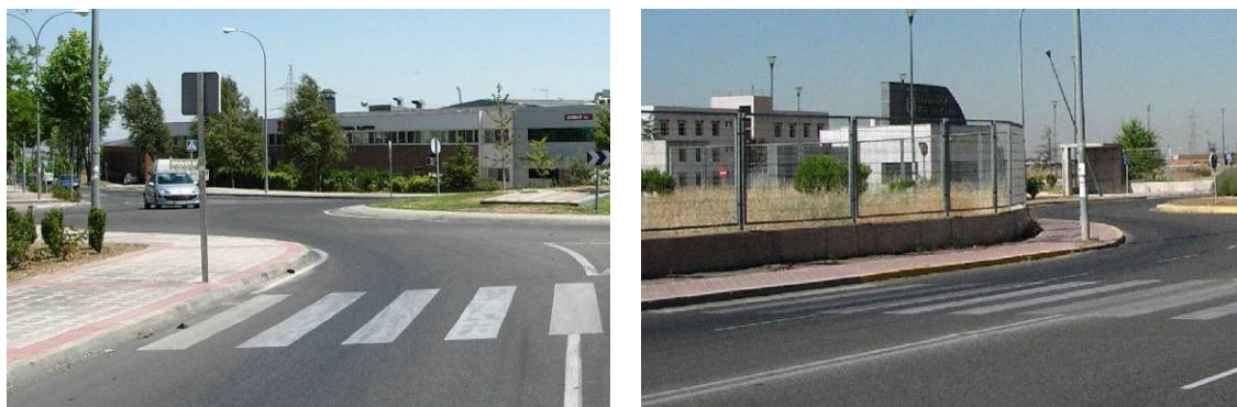
Ilustración 64 Pasos de peatones sin rebaje de bordillos. C/ Constitución y Camino del Molino
