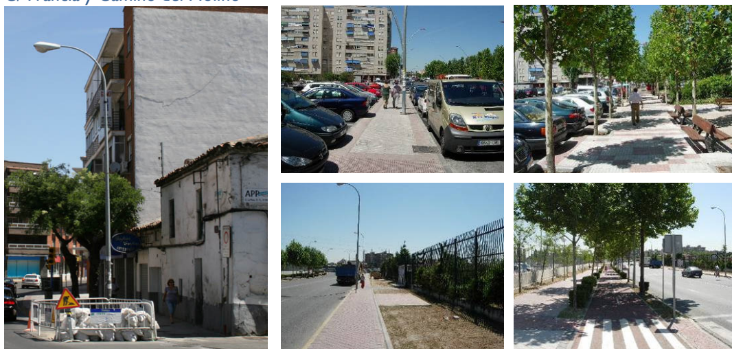
Ilustración 59 Alumbrado inadecuado en C/ Luís Sauquillo, y desequilibrio entre aceras en C/ Francia y Camino del Molino
